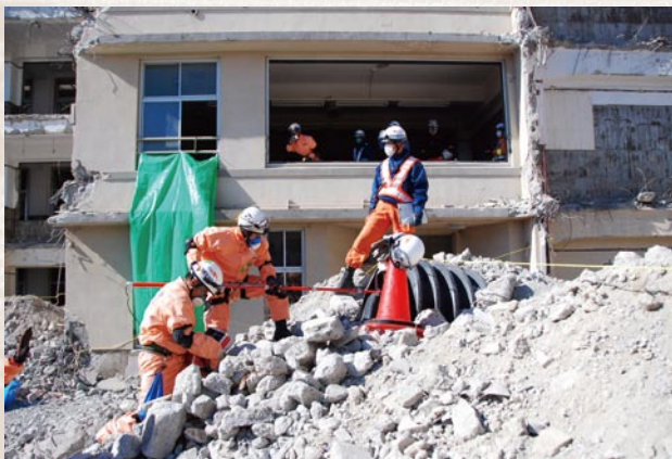
倒壊建物のガレキ下を画像探索機を使用し検索
